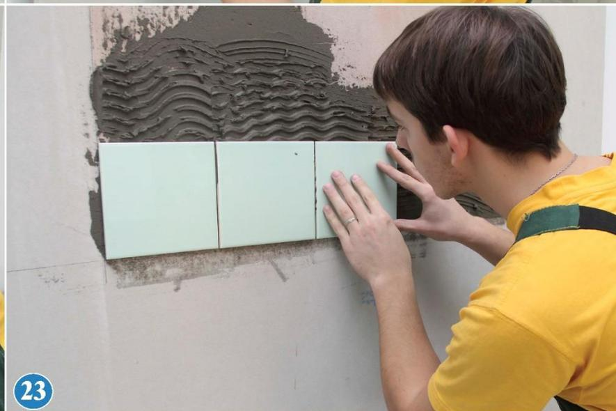
Начинайте выкладывать плитку от нижнего угла по горизонтали, оставляя шов 3 мм и легким движением вдавливая ее в раствор. Между плитками поставьте по два пластмассовых крестика, где есть граничащие ребра плиток.
