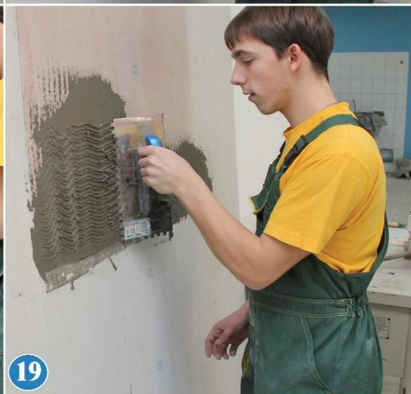
Клей наносят обычным шпателем на тыльную сторону плитки и с помощью зубчатого шпателя, у которого высота зубцов равна 6 мм, под углом в  $90^\circ$ , и равномерно его распределяют. Таким способом клеевой слой выходит ровным и с одинаковыми бороздами.
